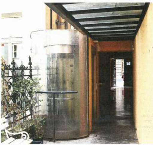
Veliko večetažnih stanovanjskih stavb je brez dvigala. Postavlja se vprašanje, ali je to družbeni ali osebni problem. © Bojan Velikonja
